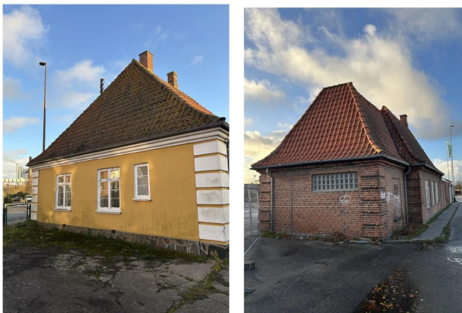
Figur 11-2 de to Administrationsbygninger ved Markedshallen og det tidligere betonværk
